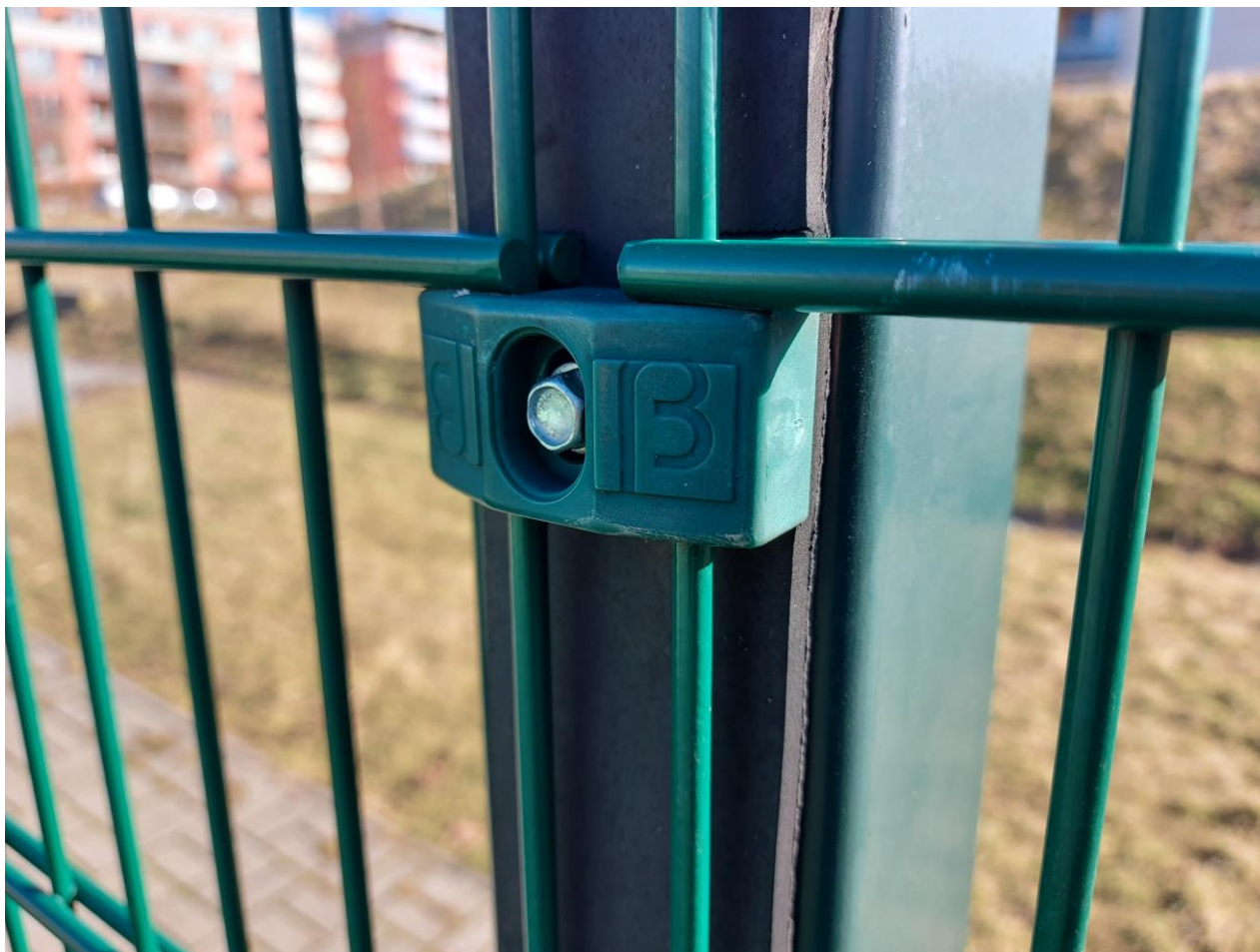
FOTODOKUMENTACE DETAILŮ RÁMOVÉHO OPLOCENÍ NAD MANTINELEM (rámová pole budou uchyceny spec.úchytkami a to na sloupech oplocení – přes pryžovou vložku nebo pás)
